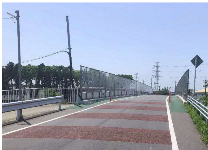
四街道市内・内黒田橋橋梁部（令和6年4月撮影）
