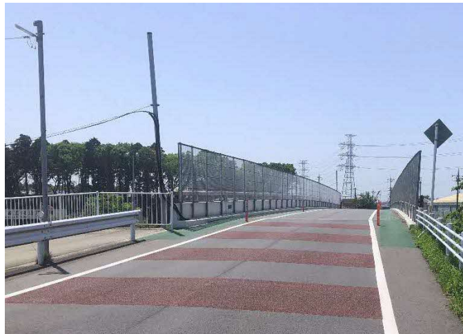
四街道市内・内黒田橋橋梁部（令和6年4月撮影）
