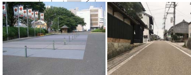
アスファルト舗装の上遮熱常温薄層舗装 脱色アスファルト (しみん広場) (第1駐車場)
