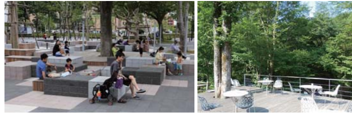
既存樹と舗装のレベル差を解消するため、樹木周りはデッキで保護
