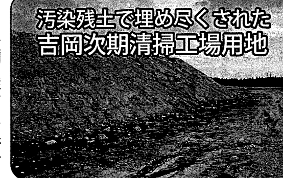
汚染残土で埋め尽くされた吉岡次期清掃工場用地
